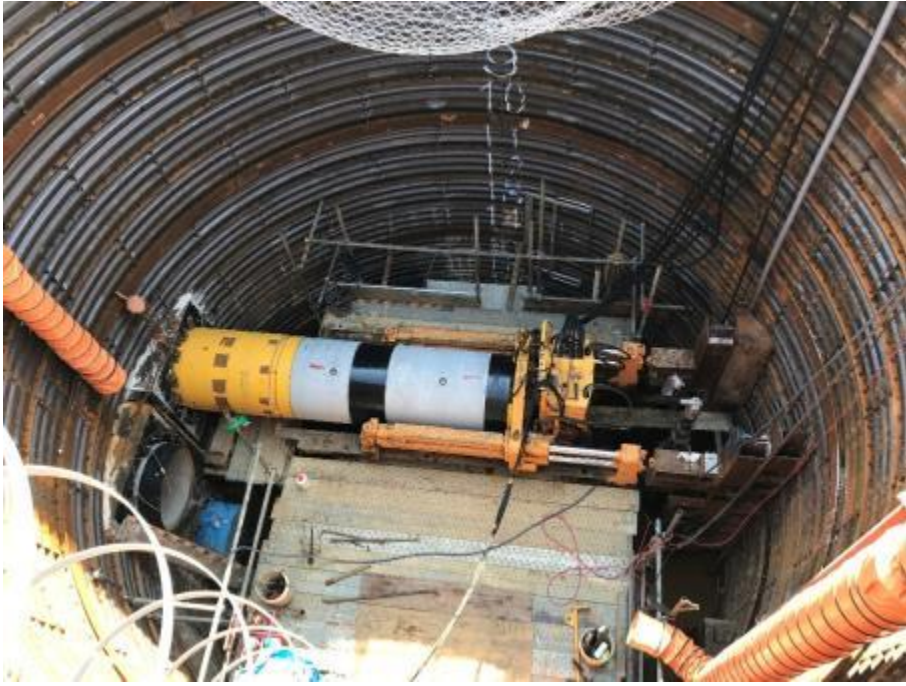
↑ 市道横断部 推進工事
