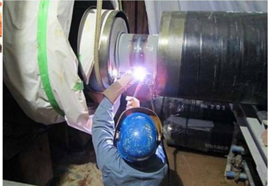
↓ 蒸気二重管（埋設部） 溶接作業
