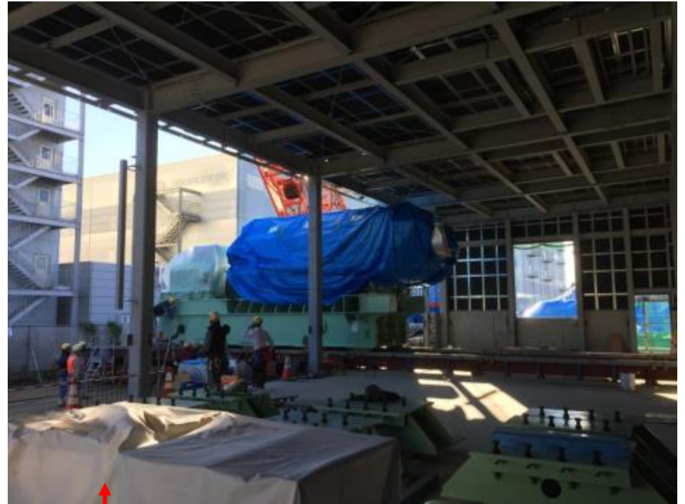
ガスエンジン1号機 搬入状況
