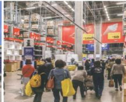
地中熱利用設備による店舗内空調
