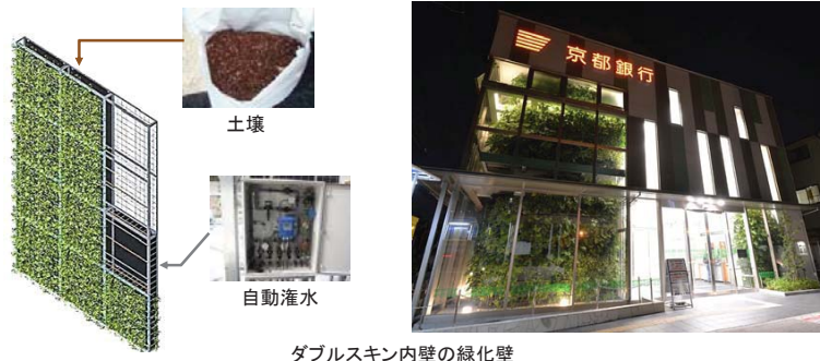
ダブルスキン内壁の緑化壁
