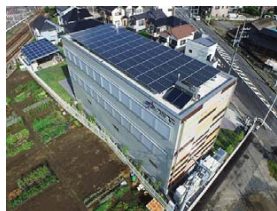
屋上設置発電設備(19kW)
